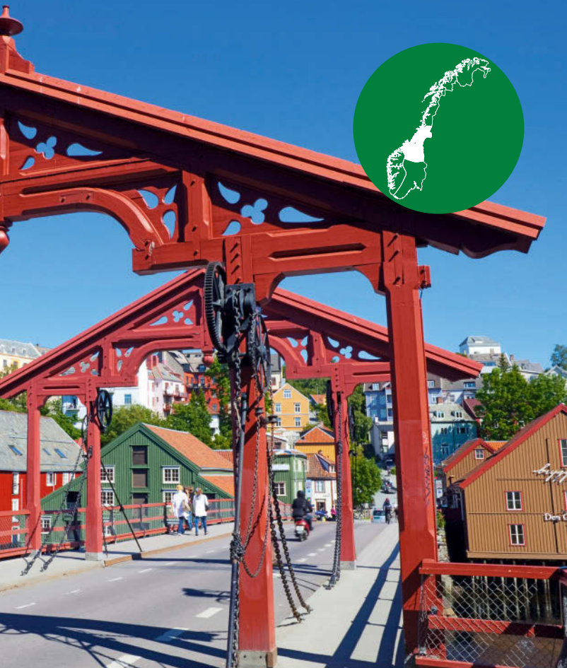
Rot leuchtet das „Tor des Glücks“ auf der Alten Stadtbrücke in Trondheim
