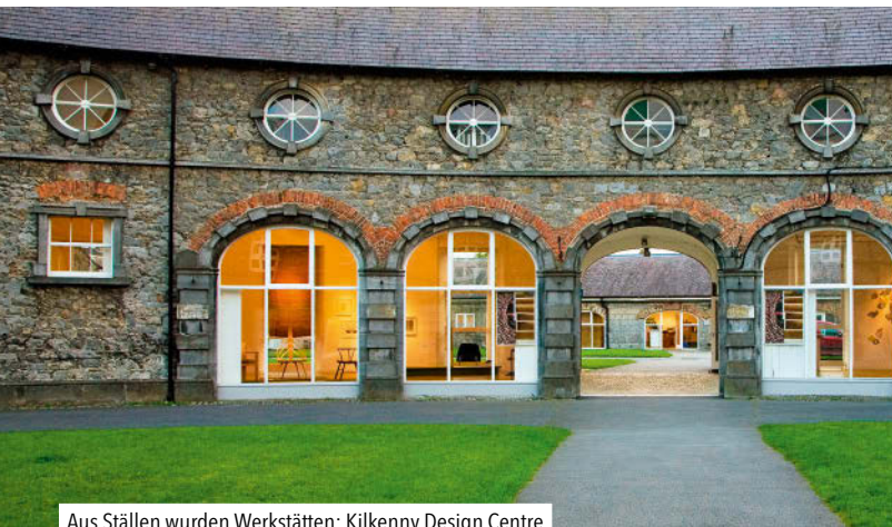
Aus Ställen wurden Werkstätten: Kilkenney Design Centre
