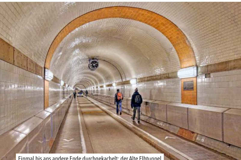
Einmal bis ans andere Ende durchgekachelt: der Alte Elbtunnel
