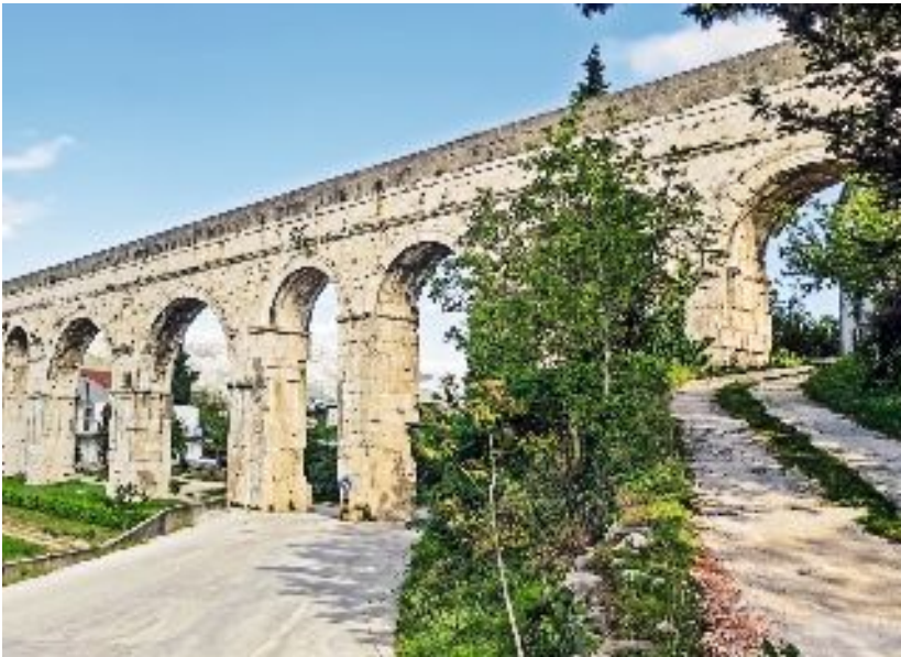
Die Brunnen von Dubrovnik wurden über eine kilometerlange Aquäduktleitung versorgt (oben). Reste eines römischen Aquädukts in Split (unten): Die Versorgung des römischen Diokletianpalasts mit Trinkwasser basierte auf einer architektonischen Meisterleistung.
