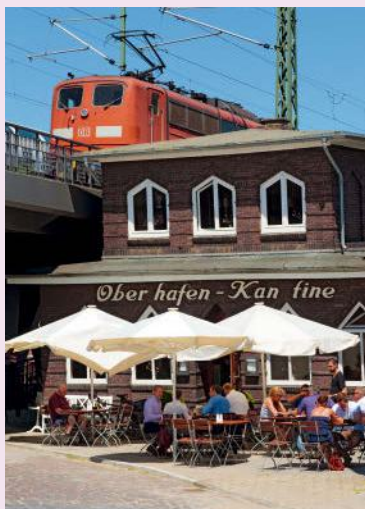
Bau mit Schlagseite: Oberhafen-Kantine
