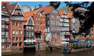
Mittelalterliche Fassaden an der Deichstraße
